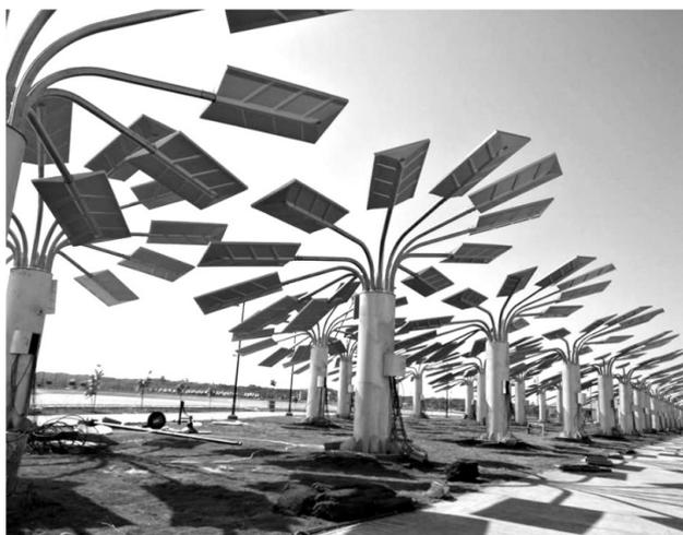
циркуляцию влажного воздуха, а машина – за вырабатывание воды из влажного воздуха. Таким образом, автономная smart-palm может вырабатывать до 55 литров воды ежедневно, а если подключить эту систему к городской сети, можно получить более 200 литров воды ежедневно и решить проблему дефицита воды. Именно так мы собираемся наладить водоснабжение
