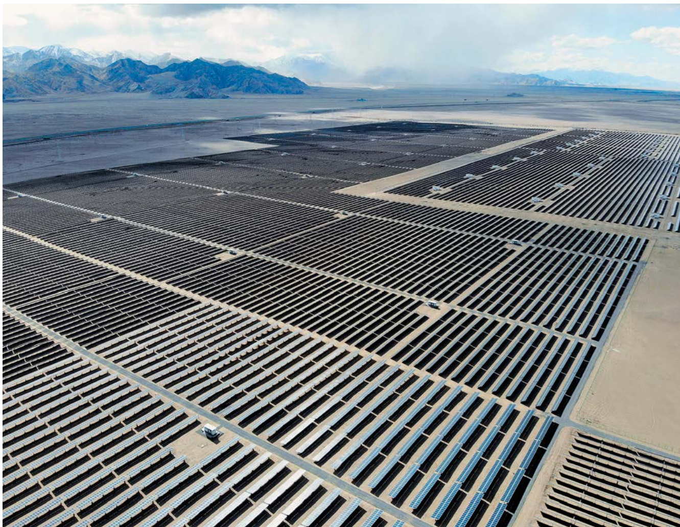
Солнечные модули в промышленном парке фотоэлектрoэнергии в городе Голмуд, провинция Цинхай, северо-запад Китая
