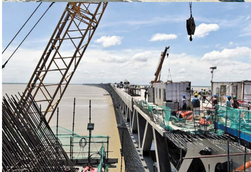
Рабочие заняты на строительной площадке проекта моста Падма
