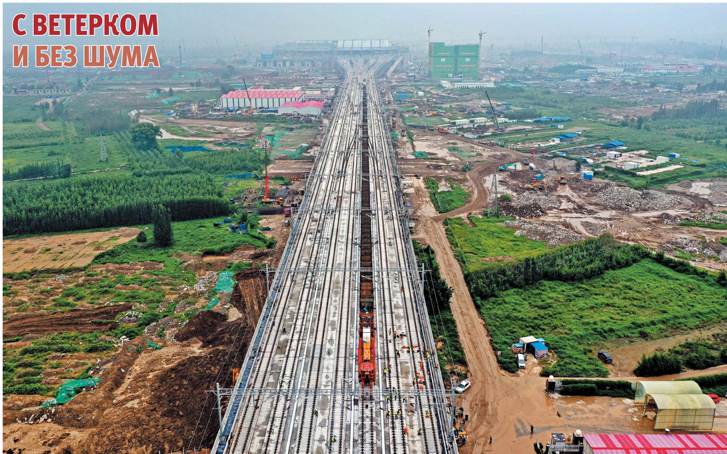
Рабочие прокладывают пути на строительной площадке междугородной железной дороги Пекин – Сюнган
