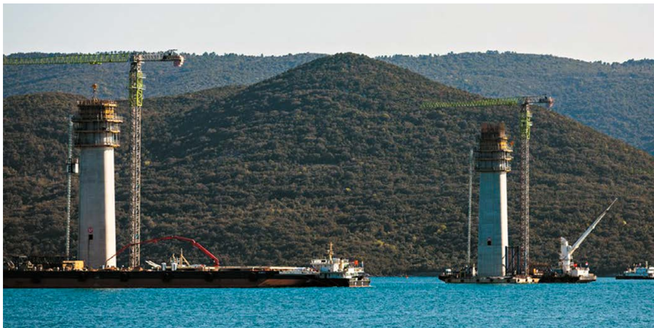
Мост Пелешац возле Комарны находится в стадии строительства, Хорватия, 17 апреля 2020 г.
