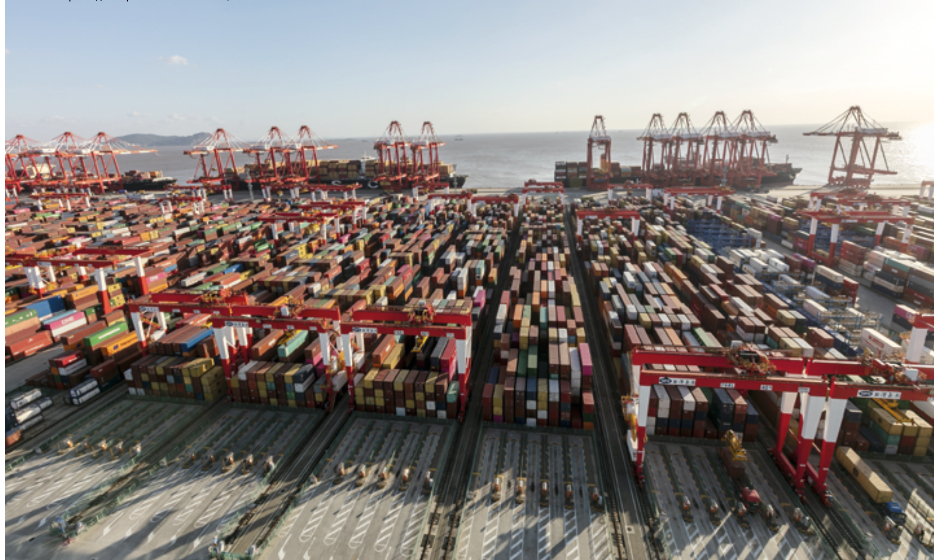
Контейнерный док порта Яншань в Шанхае, Восточный Китай
