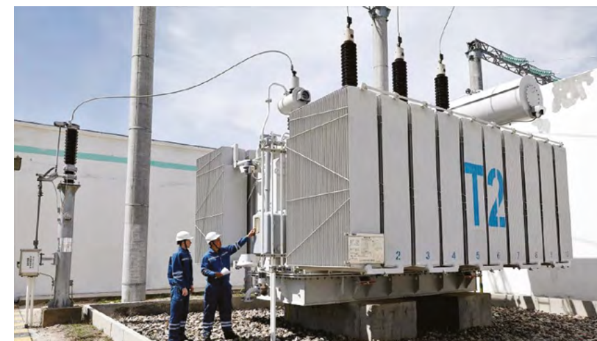
Оборудование силового трансформатора на ветровой электростанции Жанатас, Казахстан
