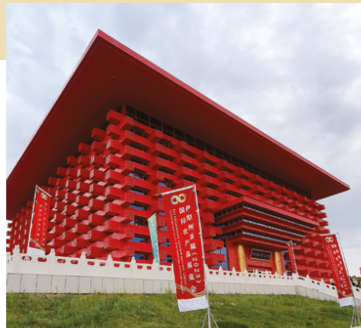
Офис для работы центральноазиатских и китайских СМИ на МЦПС «Хоргос»
