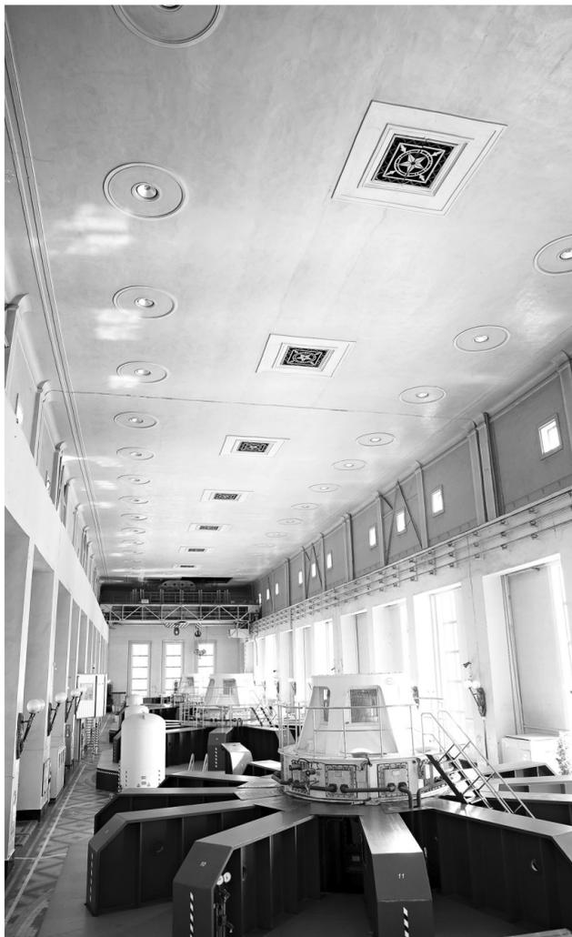
завершившейся в 2014 году; затем с 2015 по 2017 год был модернизирован ГА-2. К настоящему времени проведена модернизация трех агрегатов Усть-Каменогорской ГЭС с заменой генераторов и рабочих колес турбины. В результате установленные мощности агрегатов ГА-1, ГА-2 и ГА-3 в соответствии с номинальной мощностью турбин составляют по 95 МВт. Обновление всего гидросилового оборудования позволило увеличить мощность станции почти на десять процентов: с 331,2 МВт до 367,8 МВт.
