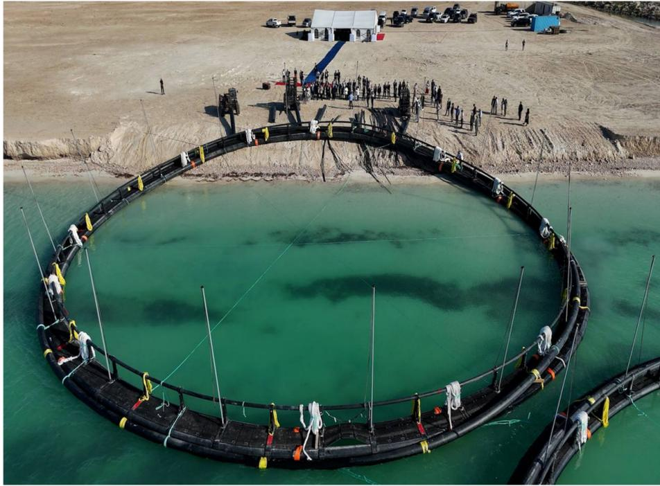
порта Курык были установлены три больших садка, сякорной системой, специально спроектированные и изготовленные в Норвегии для данной морской фермы с учетом гидрологического состояния участка. Садки будут обслуживать кормовая баржа с катерами. Доставленные в порт Курык садки были собраны отечественными и иностранными специалистами. Это самые крупные садки в истории Казахстана и Каспийского моря: каждый из них имеет окружность 120 метров и глубину 25 метров», – сообщила руководитель компании.
